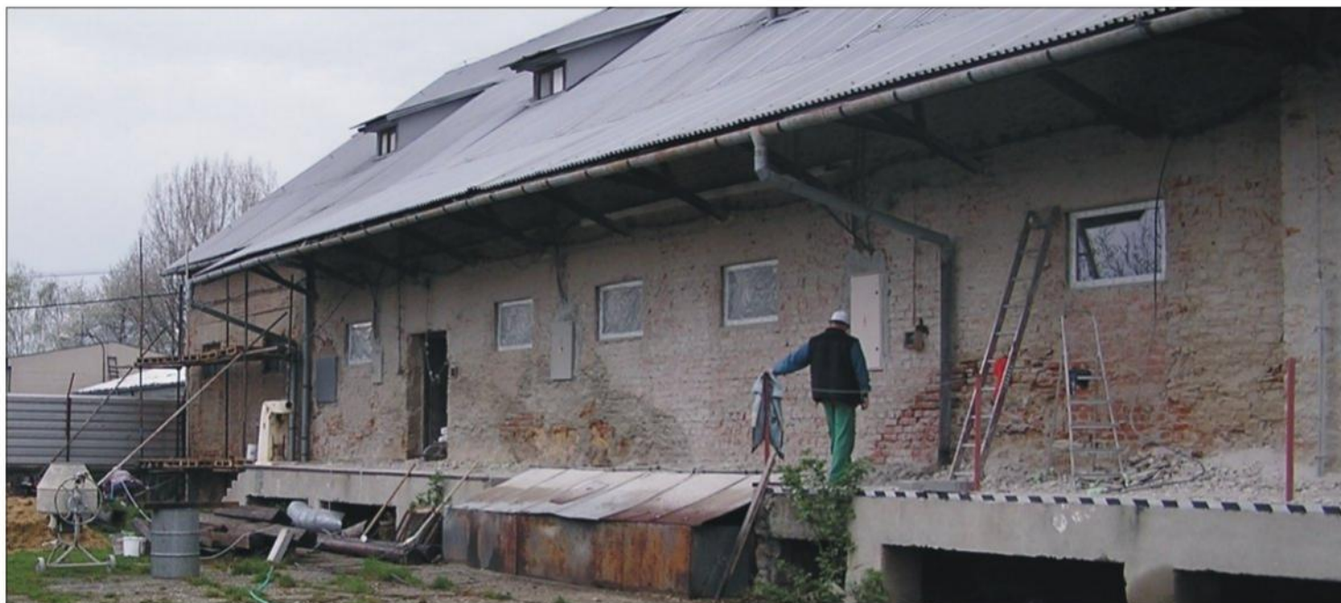
Budova bývalého obilného skladu z 19. stor. Murivo je z kameňotehly, bez hydroizolácie.
