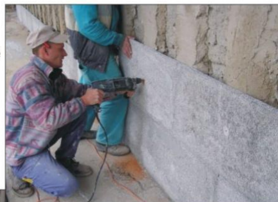
Budova bývalého obilného skladu z 19. stor. Murivo je z kameňotehly, bez hydroizolácie.
