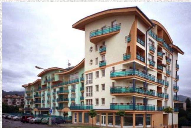
Polyfunkčný dom v Banskej Bystrici vďaka nehorľavosti Styrconu prežil požiar v r 1999
