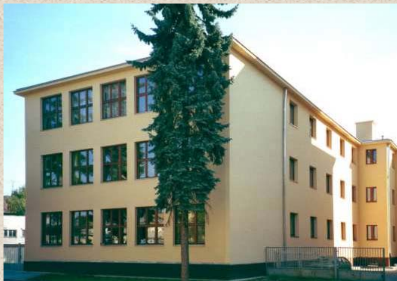
Budova školy v Nitre na Farskej ulici, pre ktorú bolo paropriepustné zateplenie ideálnym riešením
